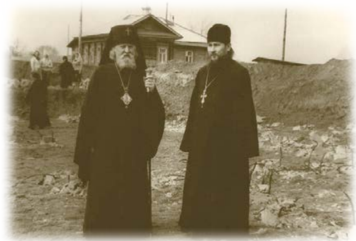
На котловане собора Святого князя Владимира, Новочебоксарск. 1989
